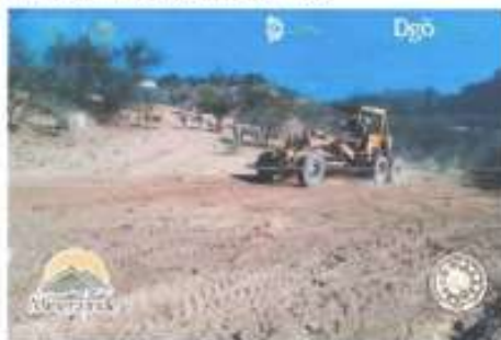
Figura 3. Nivelación del terreno
